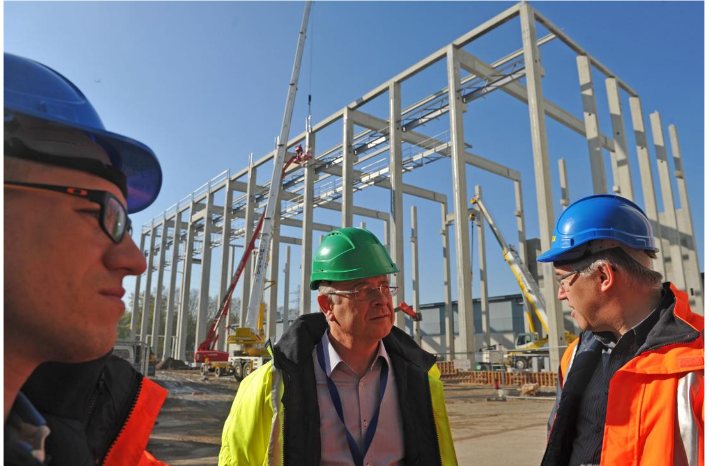
Paul Markiewicz, directeur d'IB à Brumath (centre), avec Jean-Luc Obrecht, responsable travaux neufs de Blue Paper (à d.), sur le chantier du nouveau hall de stockage dont la structure en béton mesure 26 mètres de haut. PHOTO DNA - MARC ROLLMANN
